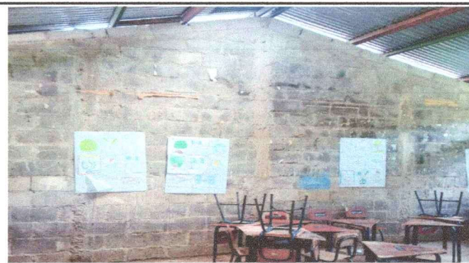
Foto 4: REPELLO DE PAREDES DE CADA AULAS.
