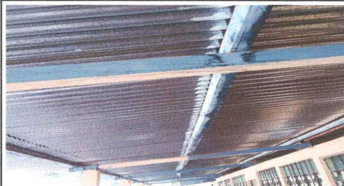
Foto 2: SUSTITUCION DE COSTANERAS Y CAMBIO DE LAMINAS A CORREDOR
