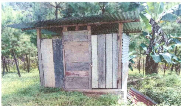
Foto 3: REHABILITACION DE PARED DE BAÑOS Y SUSTITUCION DE PUERTAS
