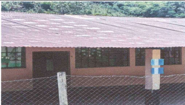
Foto 1: SUSTITUCION DE CAMBIO DE LAMINAS EN AULAS
